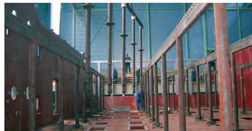
Oben: Fertigung Gleitschienen Stoßöfen. Unten: Montage Tragrahmen Hubbalkenöfen
