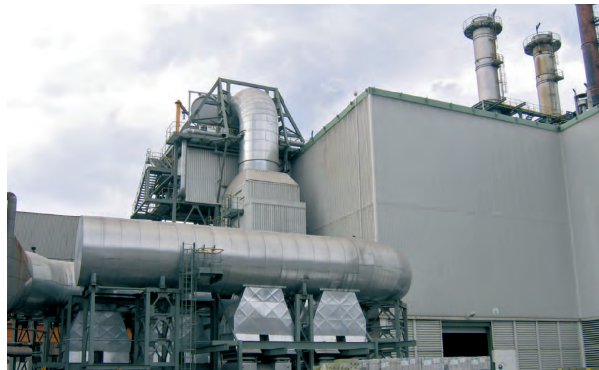
Abgaswärmenutzung nach Stoß-/ Hubbalkenöfen
