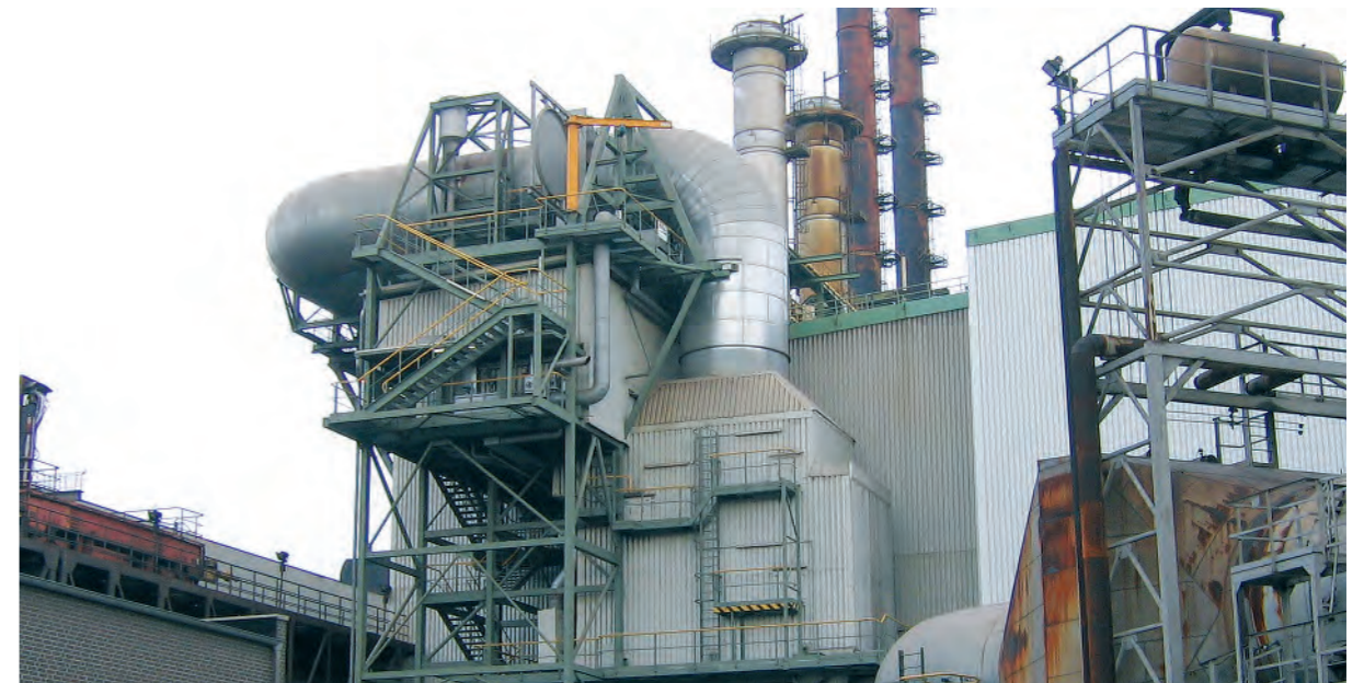
Abgaswärmenutzung nach Stoß-/Hubbalkenöfen
